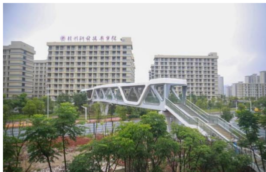
图 6-19 附属设施项目人行天桥
